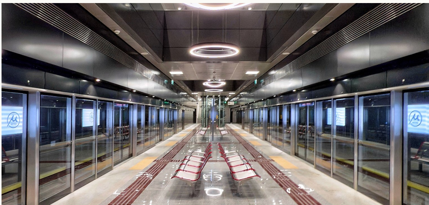
Σταθμός του Μετρό Θεσσαλονίκης. Φωτογραφία: Lambros Kazan/Wikimedia Commons, CC BY-SA 4.0.
